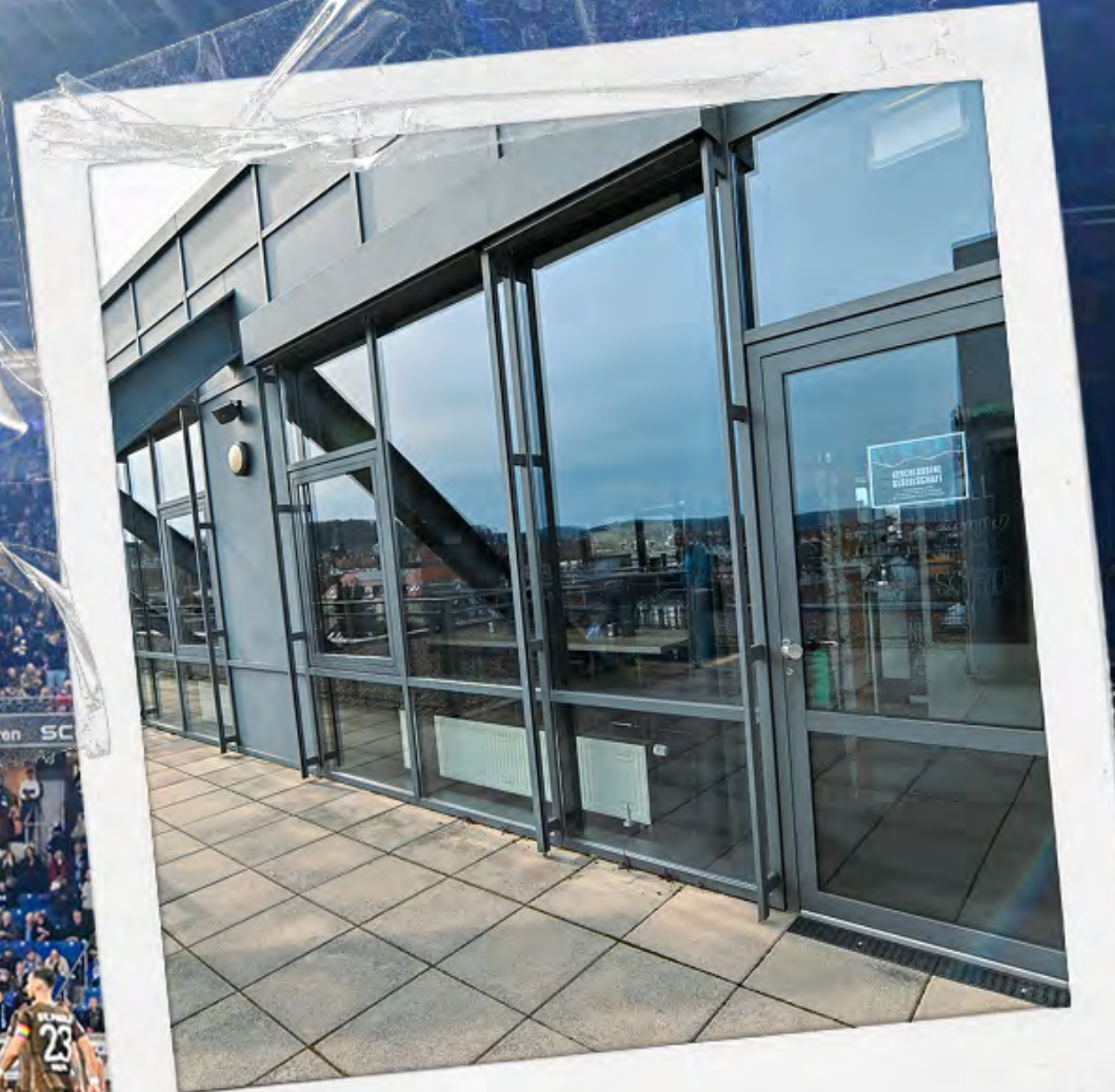
ZUGANG ZUR LOGE
